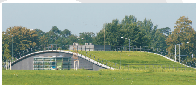
Hochwasserpumpwerk Dresden-Johannstadt (Foto: Stadtentwässerung Dresden GmbH)
